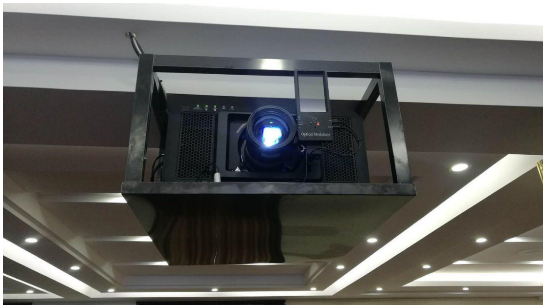
图 4.单台 DLP 投影机实现被动偏光 3D 投影
