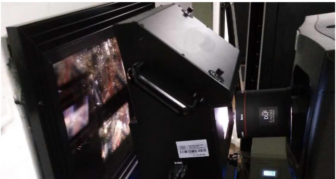
图 4.NEC 放映机 双光路 3D 设备安装实景图
